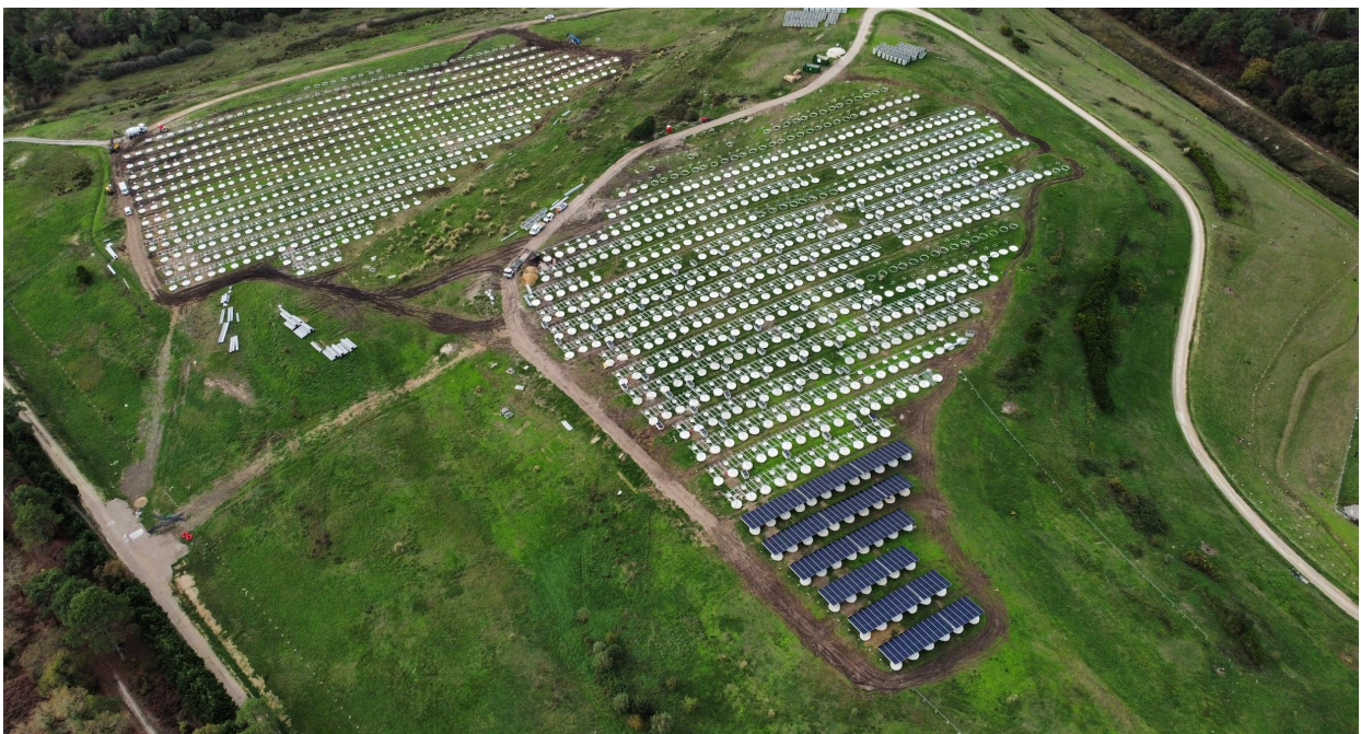
Centrale solaire du Bourgailh à Pessac - Télécharger le visuel
