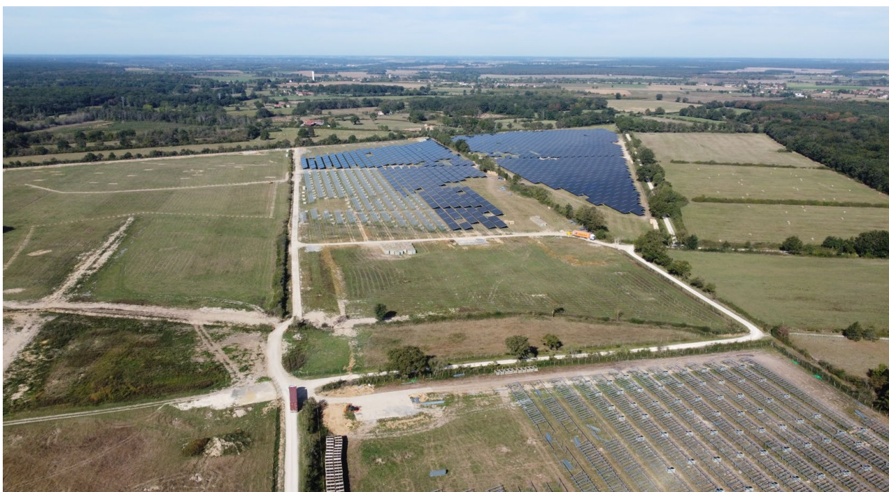
Centrale solaire d'Arpheuilles en construction, décembre 2023 (Crédits JP Energie Environnement)
